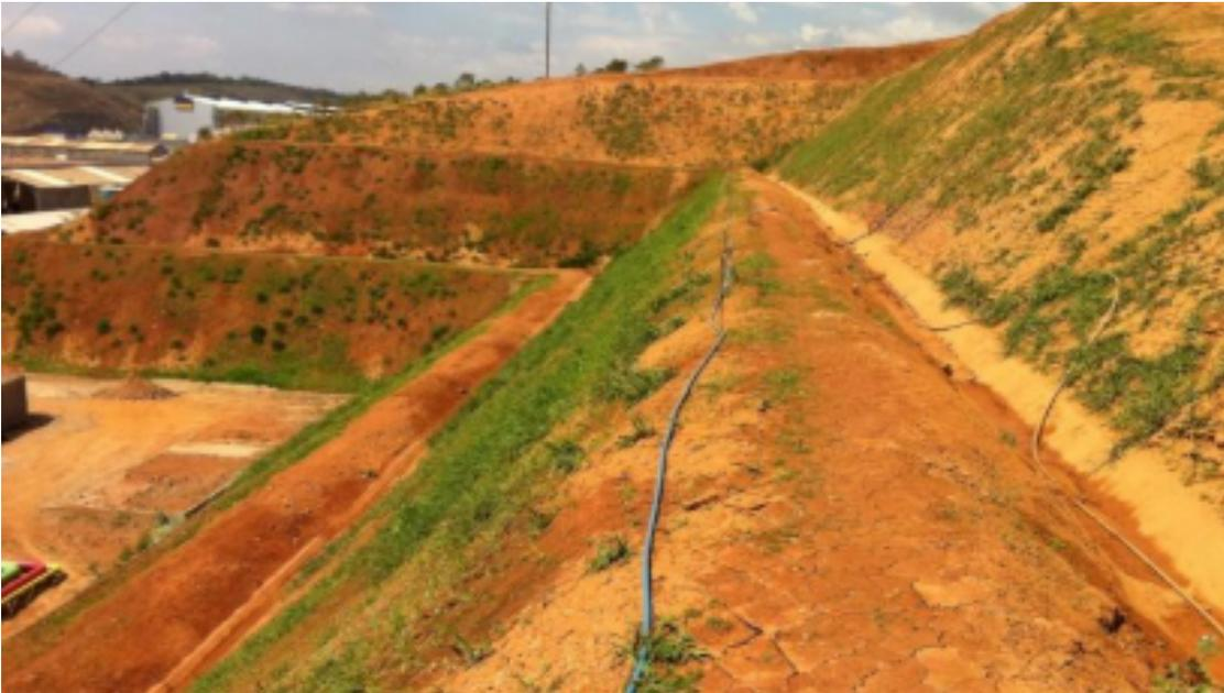
**FIGURA 5 - TALUDE CONSTRUÍDO COM O AUXÍLIO DE GEOCÉLULAS**
