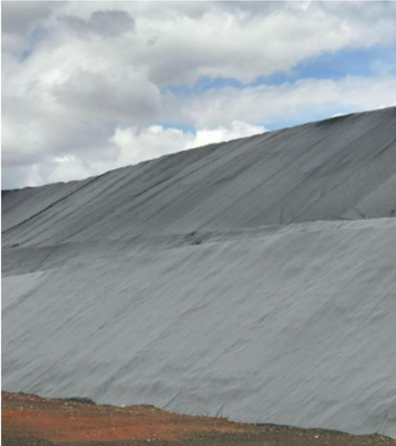
**FIGURA 2 - APLICAÇÃO DE CAMADA DE PROTEÇÃO COM GEOTÊXTIL EM TALUDE**
