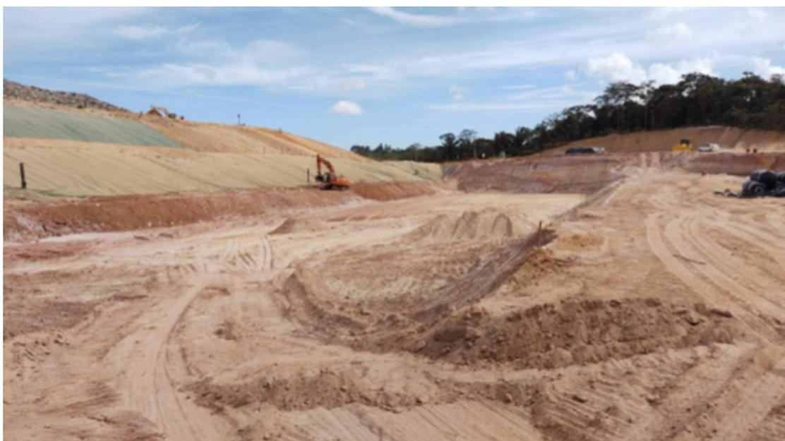
**FIGURA 1 - NIVELAMENTO PARA INSTALAÇÃO DE GEOMEMBRANAS EM UM ATERRO SANITÁRIO**
